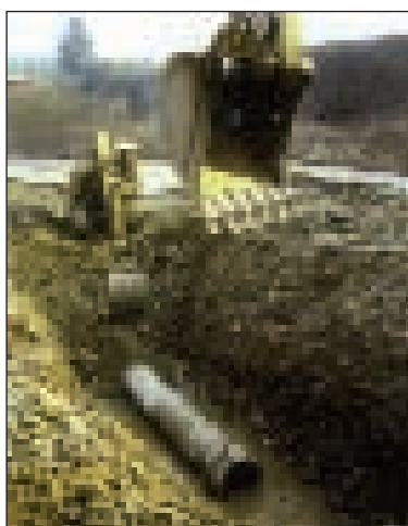
Posa dei tubi di un collettore
