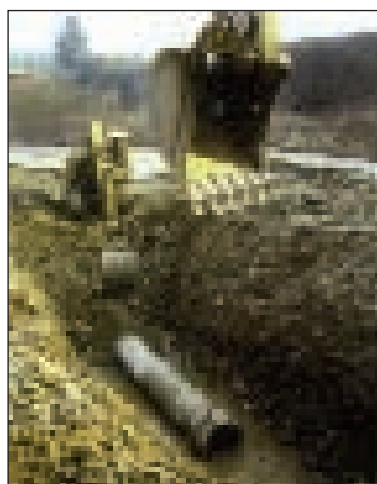
Posa dei tubi di un collettore
