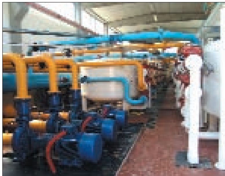
Sezione filtri di impianto di depurazione
