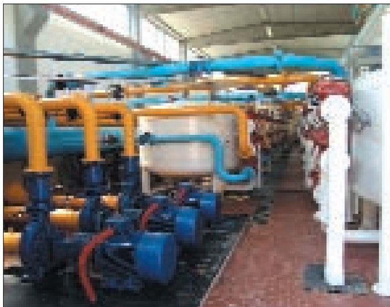
Sezione filtri di impianto di depurazione
